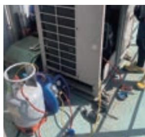
冷媒ガスを抜きます
